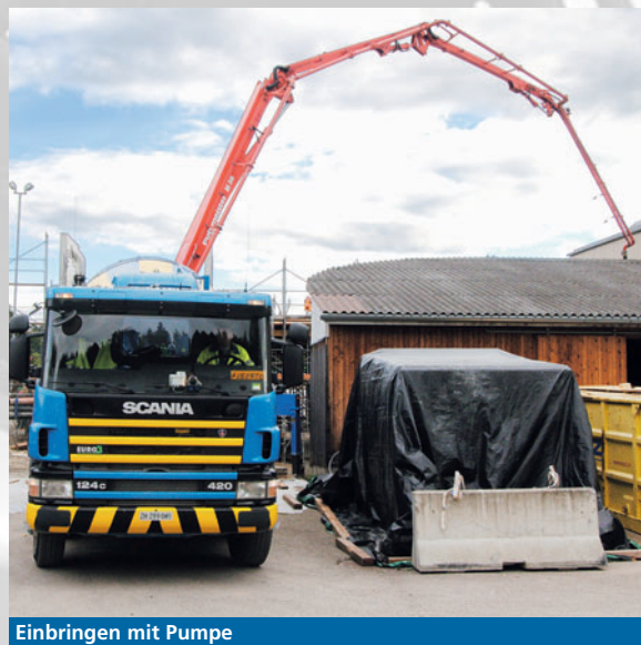
Einbringen mit Pumpe
