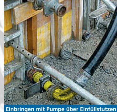
Einbringen mit Pumpe über Einfüllstutzen
