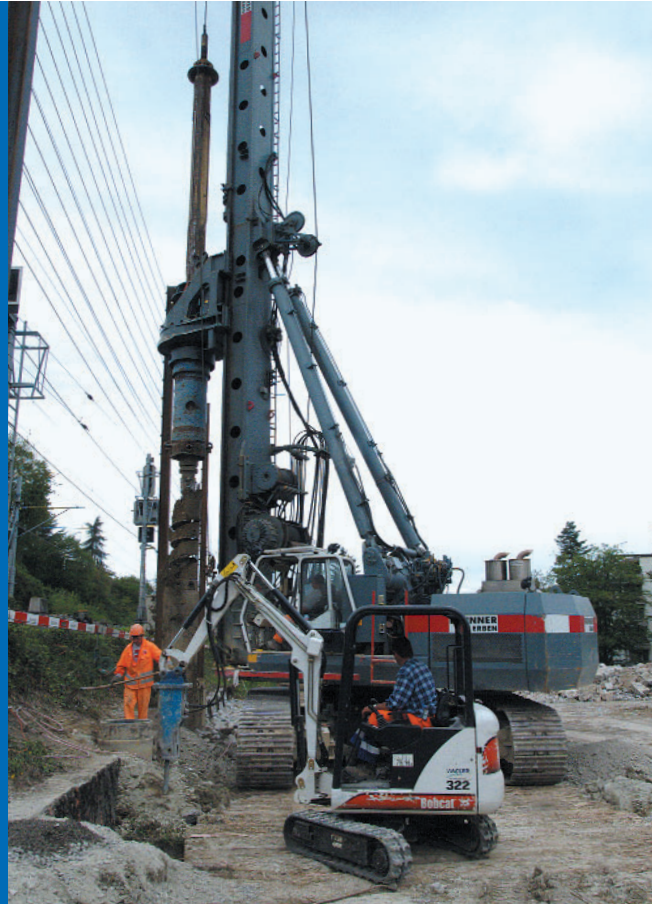
Bohren und Erstellen der Rühlwandträger.
