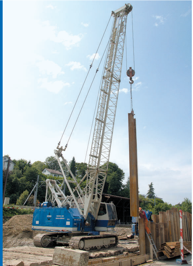
Einmessen und Einvibrieren der Spundwand.
