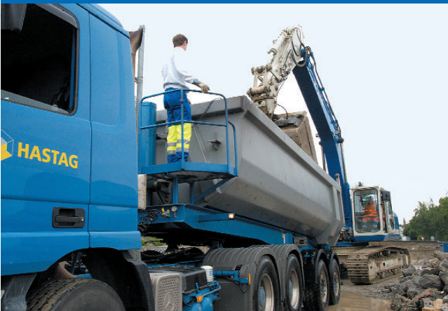
Rückbau und Abtransport der Betonmassen.
