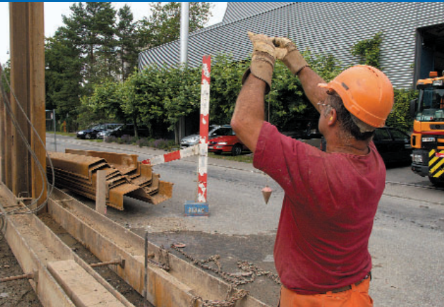
Verankern der Rühlwand.
