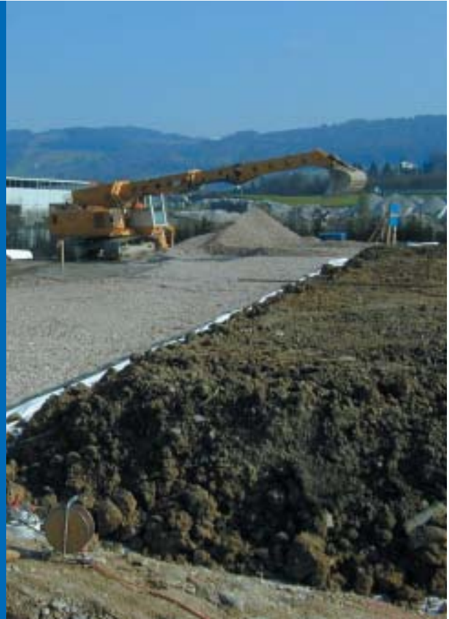
Einbau der mehrschichtigen Gasdrainage unter der Deponieabdeckung
