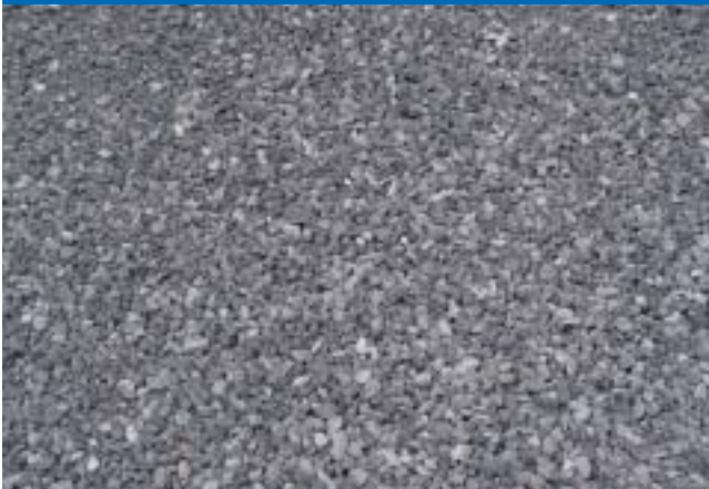
Bild oben: Abriss der Gebäudehülle Bild unten: Recycling-Granulat für die Gasdrainage
