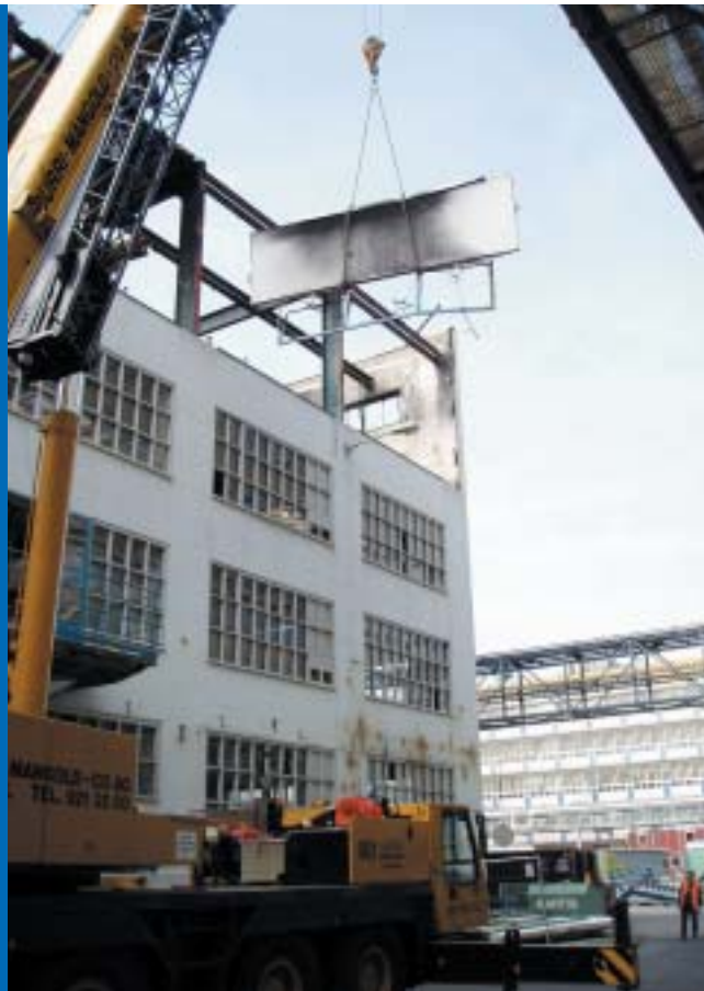
Demontage der vorgehängten Betonelemente
