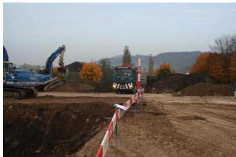
Böschung NW mit Giessereisanden
